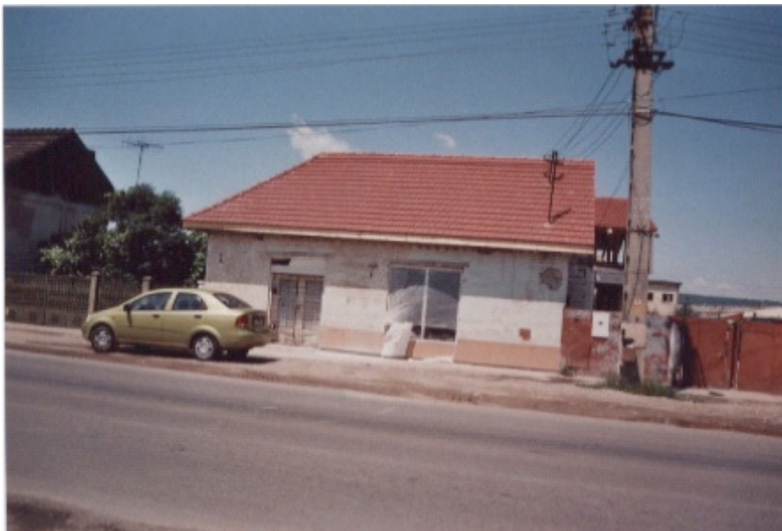
Bild 4. Das Haus gesehen von der Straße 10. 07. 2006 während der Renovierung
