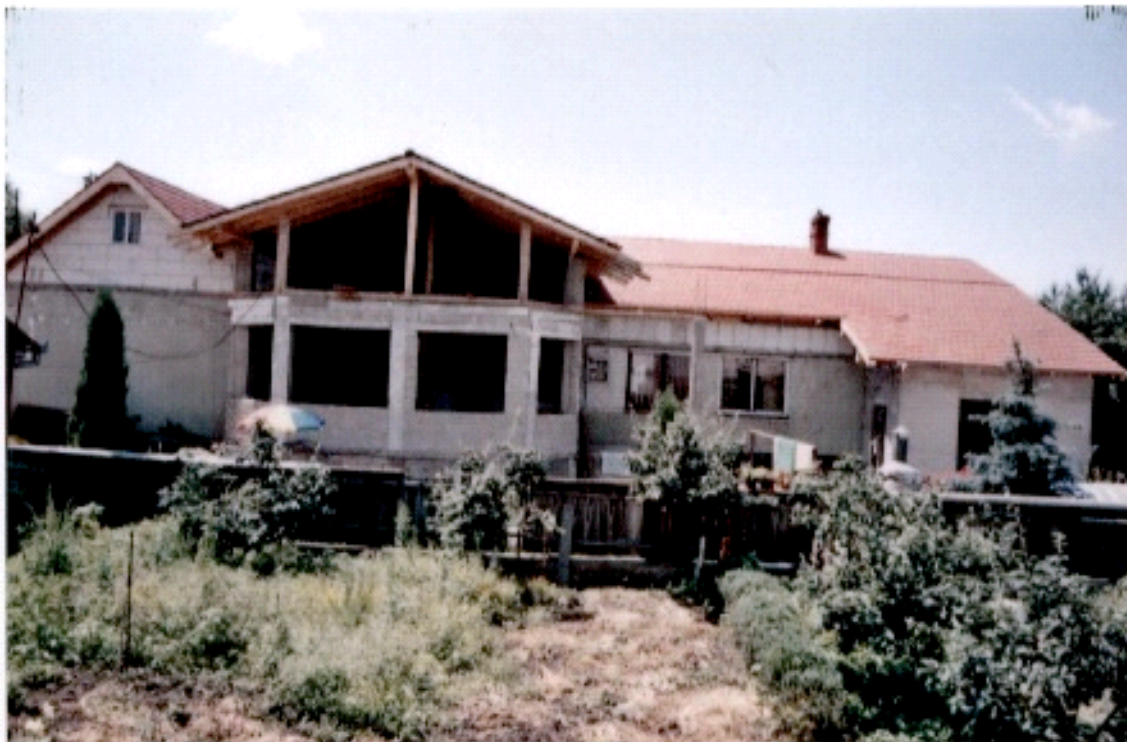
Bild 2 Das Haus gesehen von der Hofseite Juli 2006 mit dem Neubau. Die expansion erfolgte sowohl dem Hof zu als auch vom Schornstein nach hinten.
