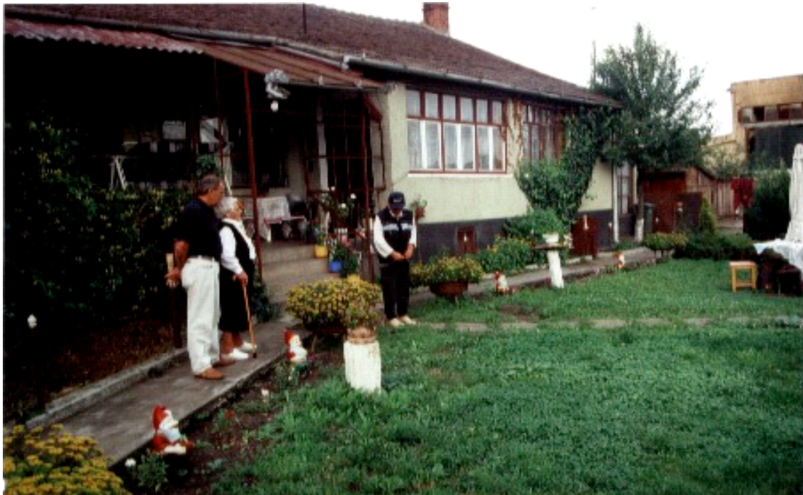
Bild 1 Das Haus gesehen von der Hofseite im Juli 2005, vor der Antragstellung auf Restitution. Neu ist nur der Gehsteig und eine marode Blechüberdachung
